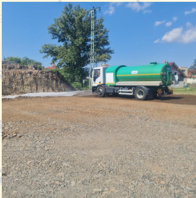
Obr. 15: Dokumentace Zhotovitele, zajištění optimální vlhkosti při hutnění
