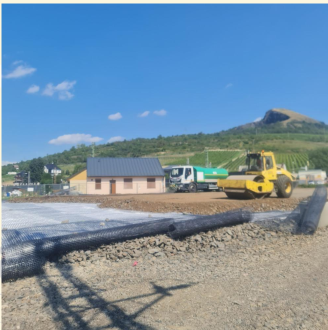
Obr. 14: Dokumentace Zhotovitele, hutnění vrstev náspu
