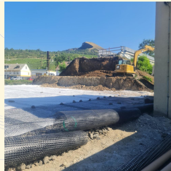
Obr. 16: Dokumentace Zhotovitele, ukládka geomříží
