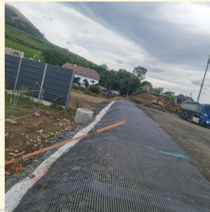
Obr. 18: Dokumentace Zhotovitele, pohled s cca km 39,630 po směru staničení
