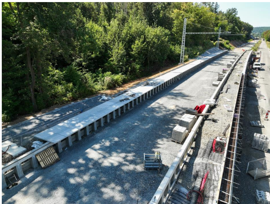
Obr. 4 – Železniční zastávka Rosice u Brna – průběh realizace (zdroj Subterra a.s.)
