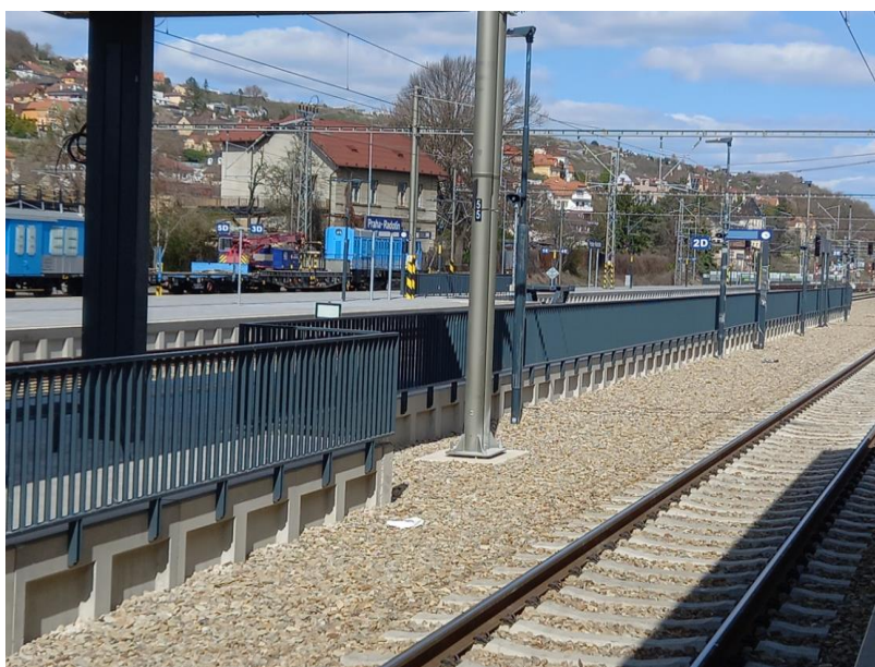
Obr. 7 – Zábradlí kotvené do nástupištního prefabrikátu, žst. Praha-Radotín
