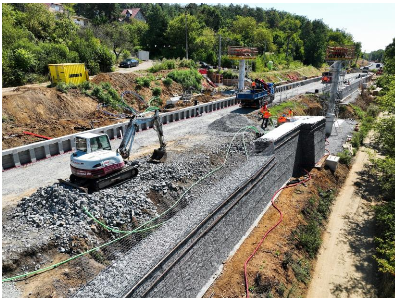
Obr. 2 – Zastávka Omice – průběh realizace (zdroj Subterra a.s.)
