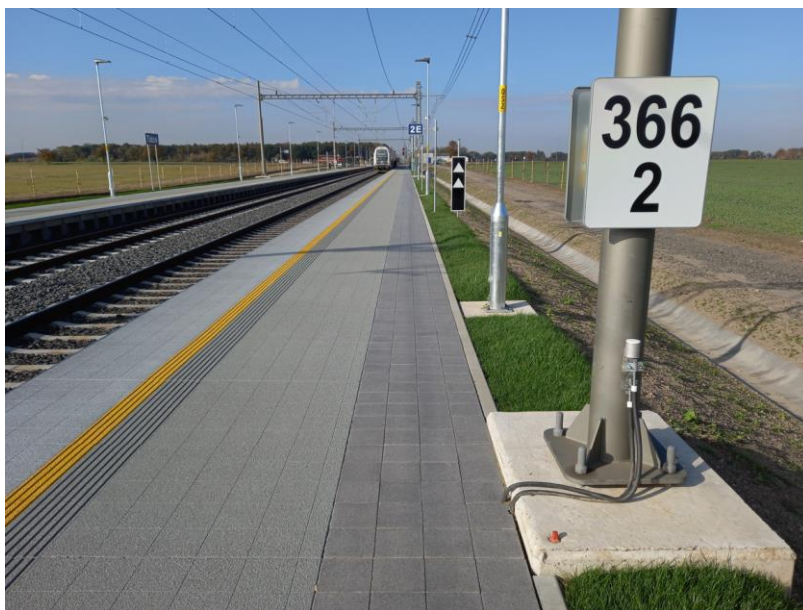
Obr. 6 – Technologická lavička za nenástupní hranou, zast. Tatce
