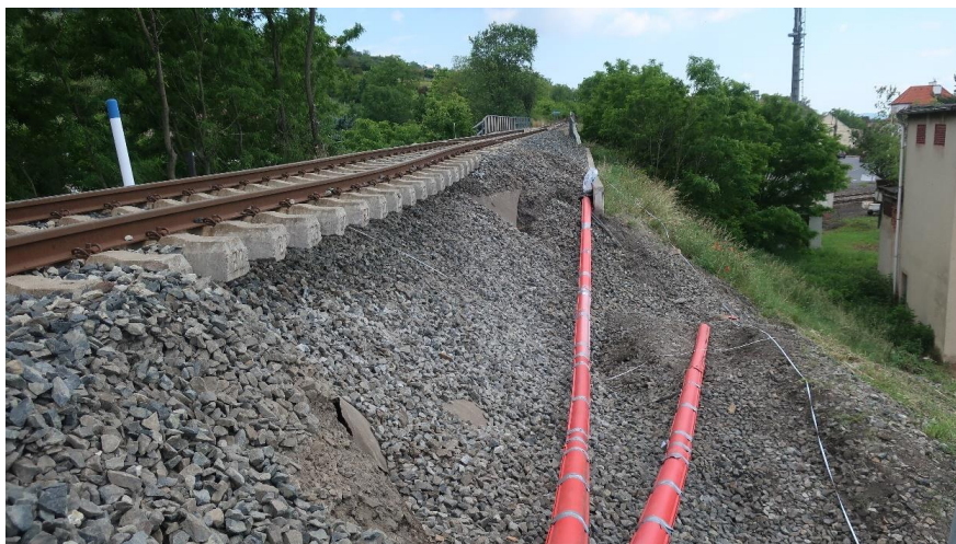
Obr. 1 – Rozsah sesuvu v km 39,700 ÷ 39,720
