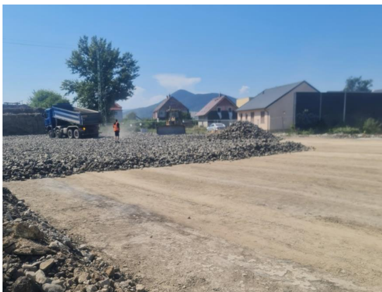
Obr. 3 – Provádění konsolidační vrstvy, pohled proti směru staničení z km 39,700
