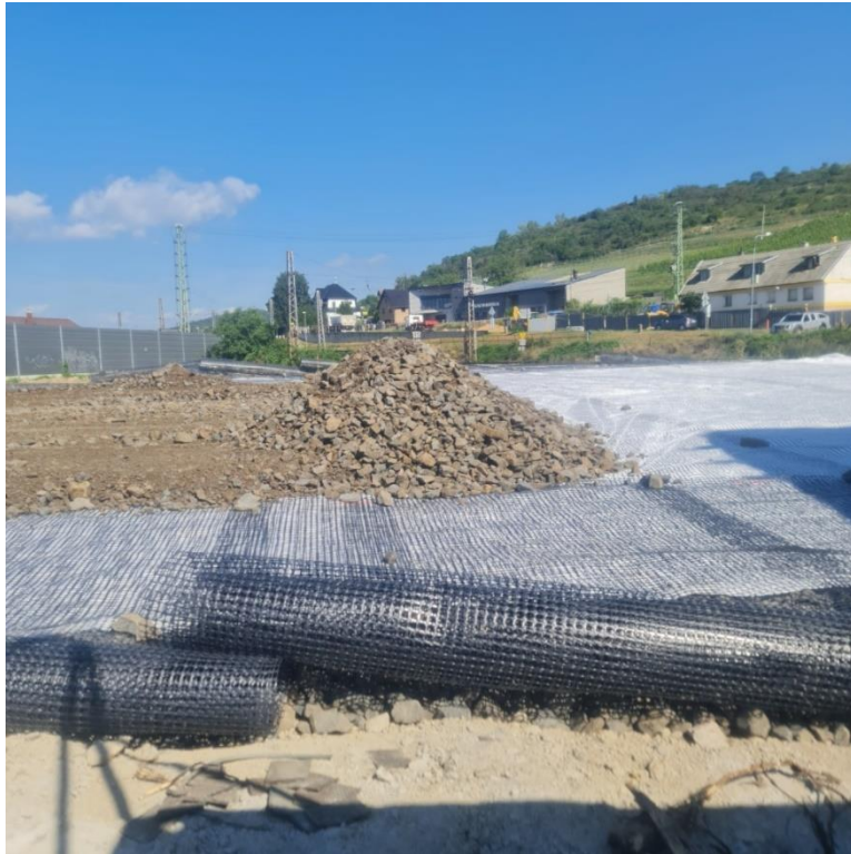
Obr. 4 – Provádění 1. technologické vrstvy, pohled z km 39,650 kolmo ke směru trati
