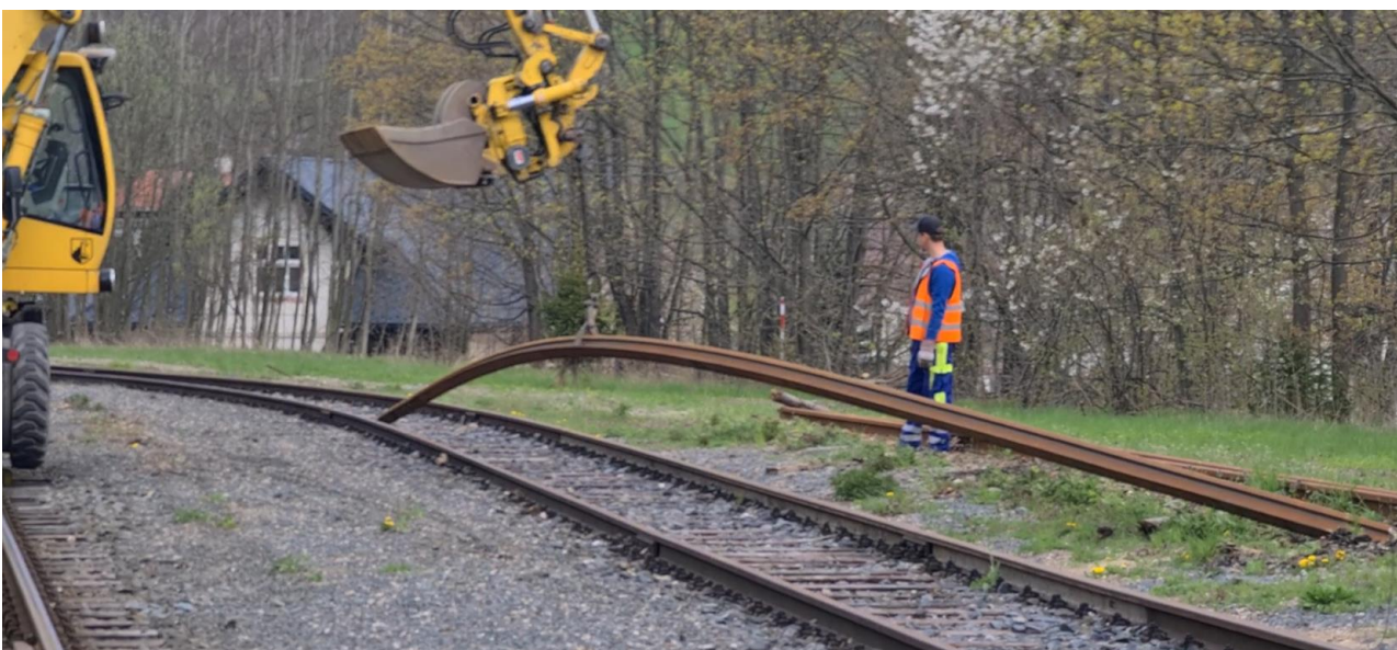
Obr. 8 – Příklad nedovolené manipulace s kolejnicemi
