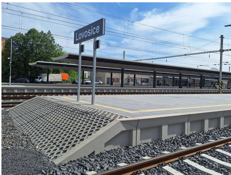
Obr. 5 – Ukončení nástupišť svahem 1:2, žst. Lovosice
