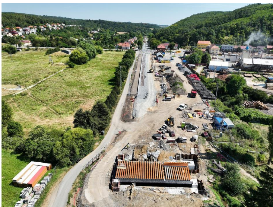
Obr. 3 – Železniční stanice Tetčice – Bobrava – průběh realizace (zdroj Subterra a.s.)
