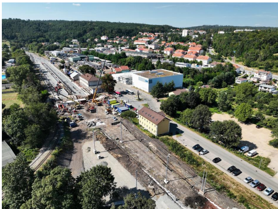
Obr. 5 – Železniční stanice Zastávka u Brna – průběh realizace (zdroj Subterra a.s.)
